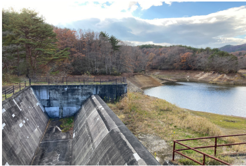
▲ 岩部ダムの堤体
