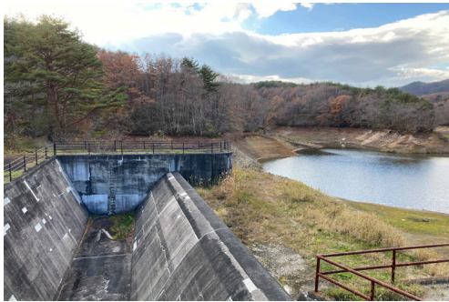
▲ 岩部ダムの堤体
